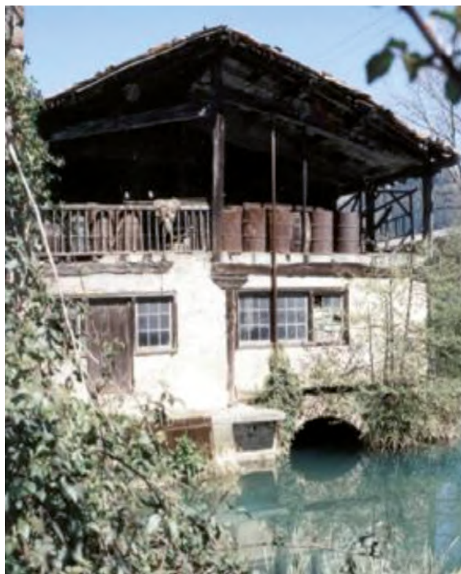
Figura 40b - Ferrería Miqueldi antes de su demolición, cliché: Urien
